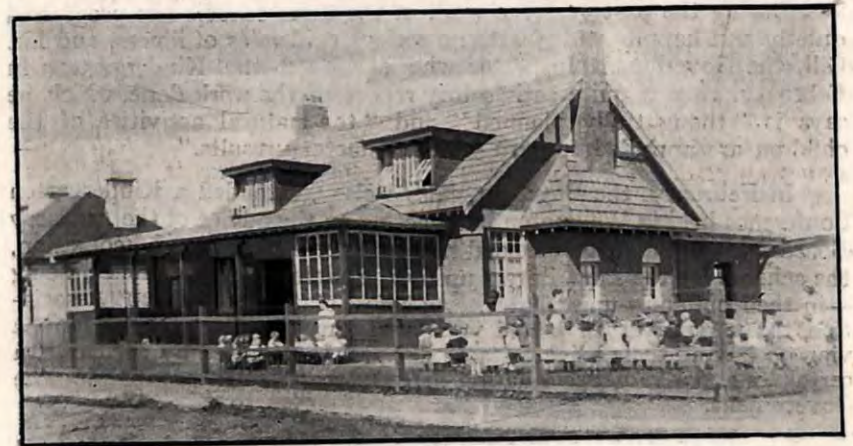
R. S. Reynolds Kindergarten Exterior
